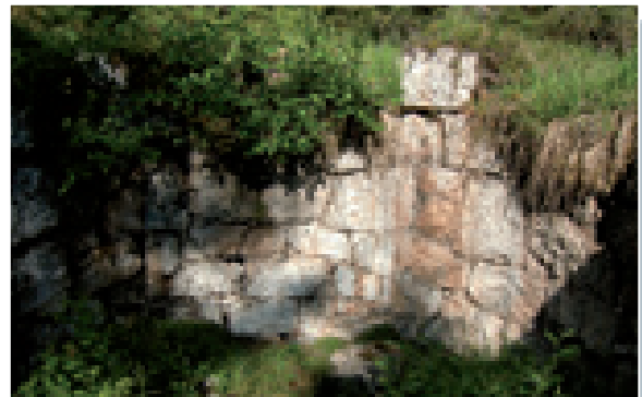
Cencenighe Agordino, resti della fornace in località Cavarzan
