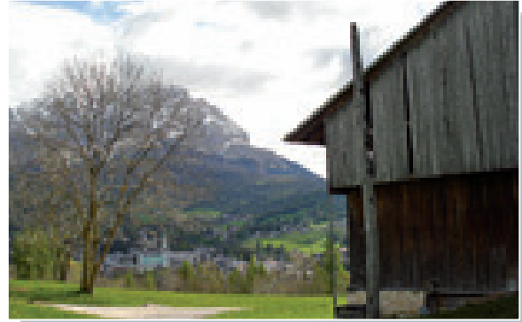
Cortina d'Ampezzo, località Mortisa, parte della struttura portante di un arfa
